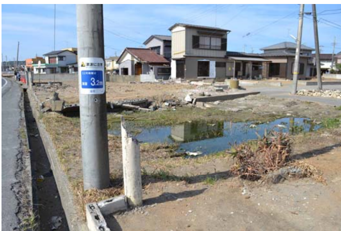
1 飯岡海岸付近の住宅地の津波被害
