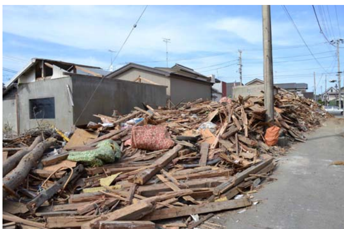
5 飯岡海岸付近の住宅地の津波被害 道路や路地に沿って津波が駆け抜け住宅地に大きな被害と多数の犠牲者を出した。
