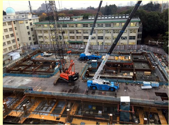
工事現場写真（平成28年12月撮影）
