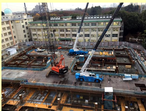
工事現場写真（平成28年12月撮影）
